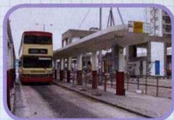
公共交通交匯處 Public Transport Interchange
